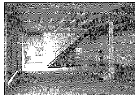
写真2 改修前の内観
